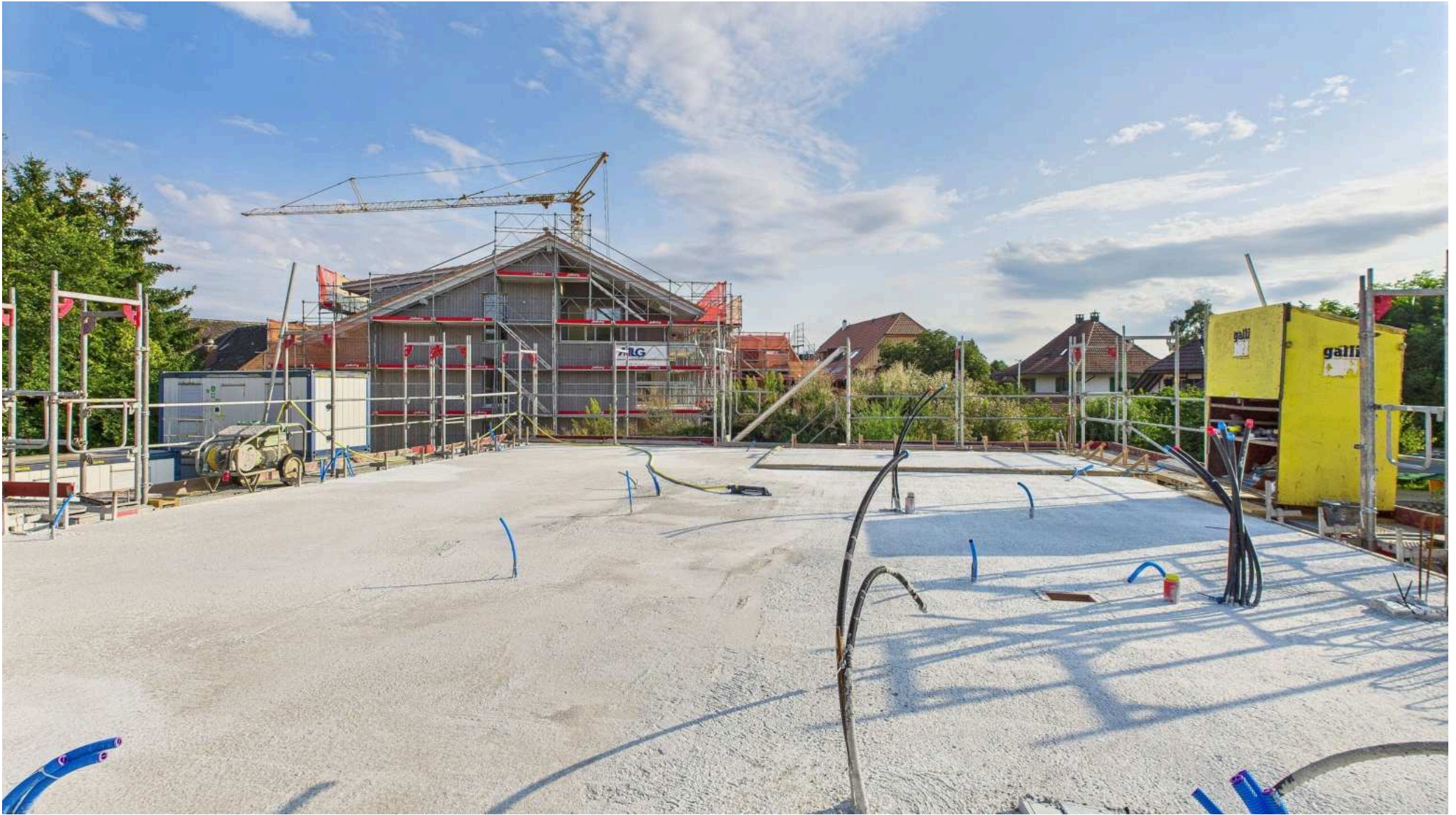
Auf dieser grossen Fläche entsteht die Wohnung (Foto 5.8, 18.15 Uhr)
